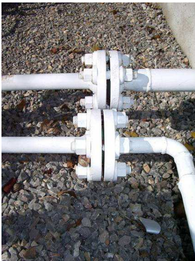
Exemple de joint isolant avec montage à brides
